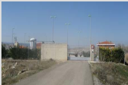
Depuradora de Calatayud
